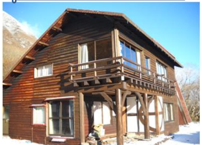
改修後の外観(平成25年末)
